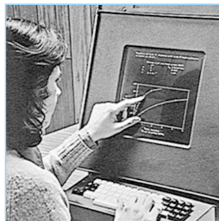
Bild 6: PLATO-IV-Plasma-Touchscreen Anfang der 70er Jahre (Quelle: University of Illinois at Urbana-Champaign, http://www.chem.uiuc.edu/clcwebsite/history.html )
