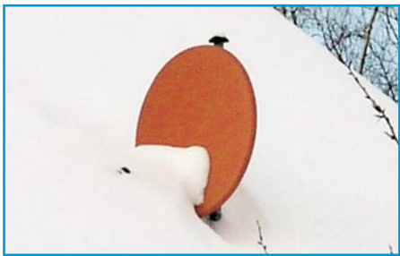
Bild 5: Je spitzer der Winkel zwischen First- und Antennenrichtung, desto leichter wird der LNB eingeschnitten.
