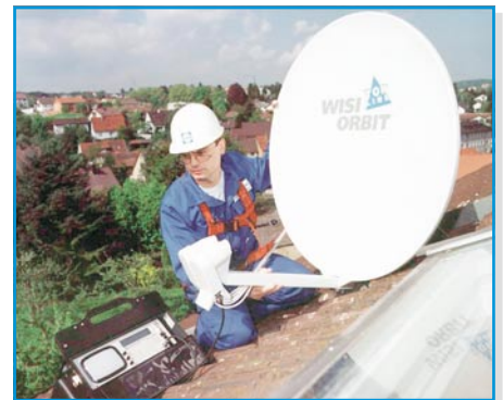
Bild 21: Gegen Absturz sichern!
