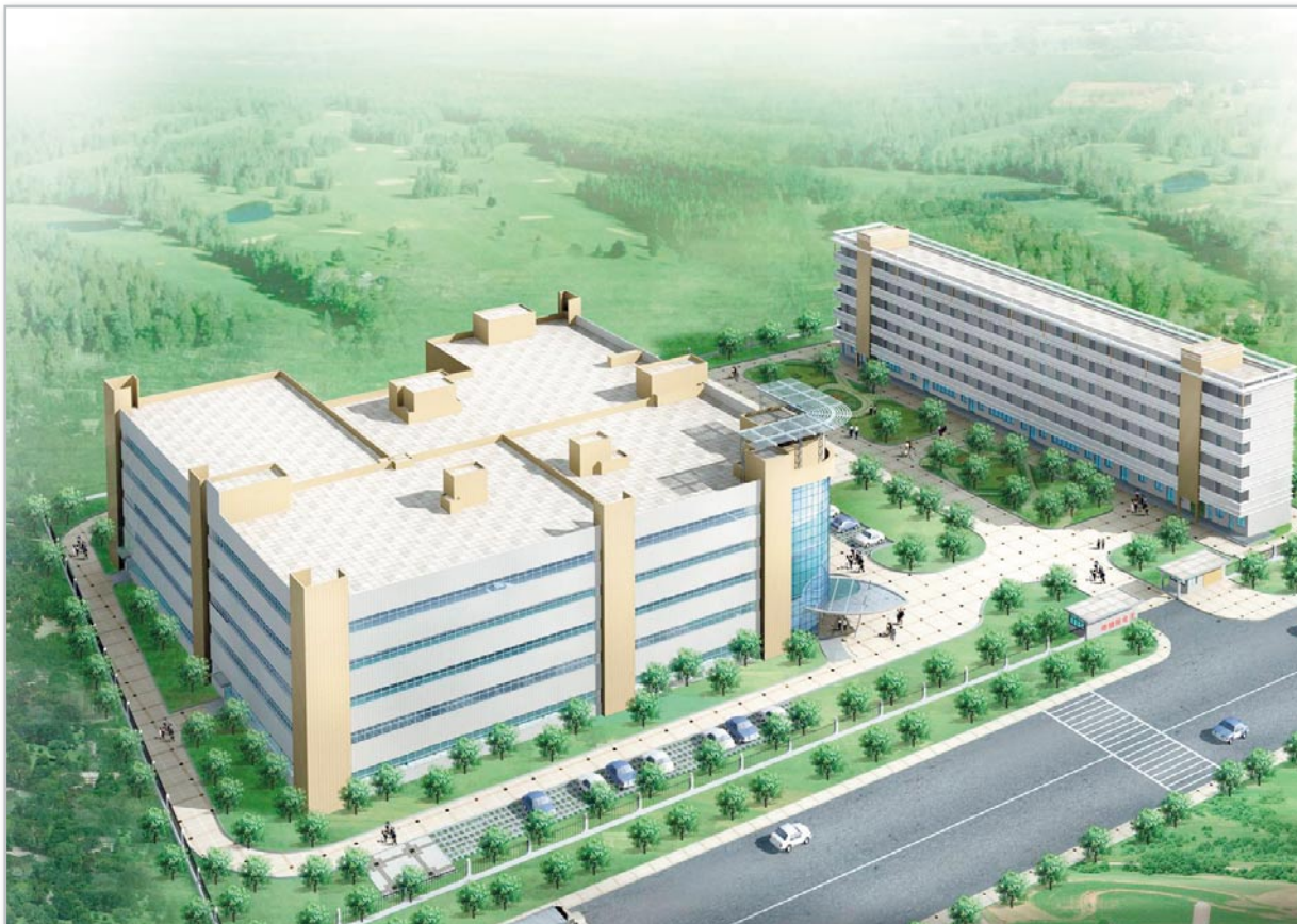
Bild 2: Das neue Produktionsgebäude aus der Vogelperspektive
