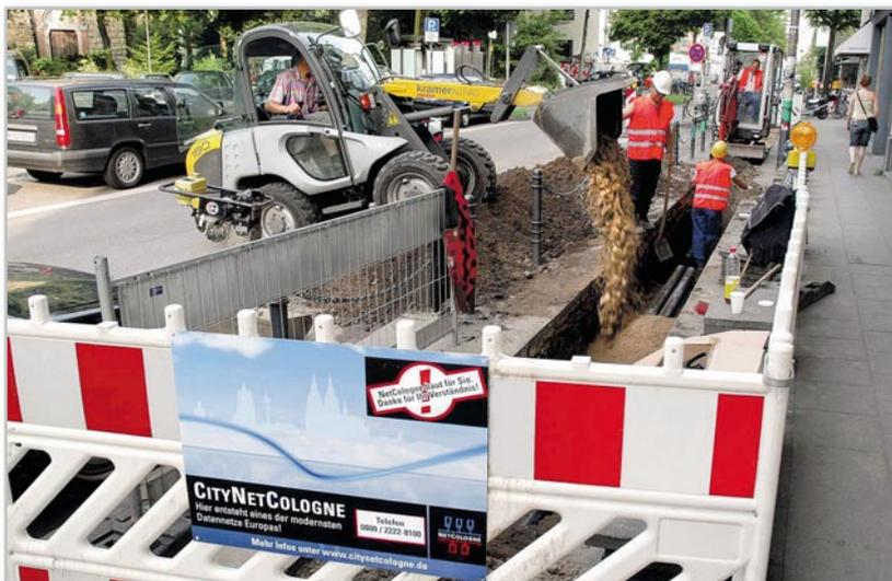
**Bild 13:** In Köln werden nach dem Glasfasernetzausbau bis in die Gebäude hinein 100 Mbit/s und mehr für den Teilnehmer verfügbar sein. Dagegen fehlen in den meisten Fällen leistungsfähige Verteilungsanlagen in den Wohnungen.
