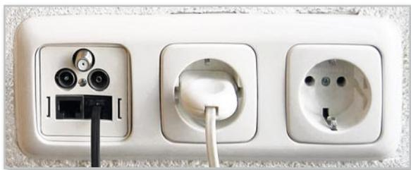
**Bild 10:** Multifunktionsdosen sind für Multimediaanwendungen eine gute Lösung. Stets müssen dabei einige 230-V-Steckdosen vorhanden sein, um die Endgeräte mit Betriebsenergie versorgen zu können. (Quelle: Reichle&De-Massari)
