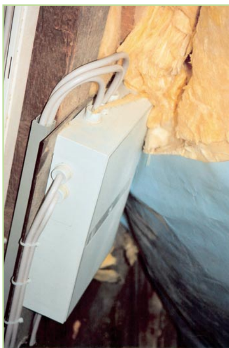
Bild 4: Separater Verteiler für die sichere Montage und Verdrahtung der elektronischen Transformatoren.
