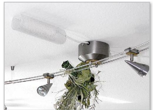
Bild 2: Die Funk-Dimmer sind in einer gefälligen Lochblech-Abdeckung untergebracht.
