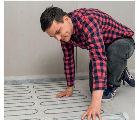
Kalte Füße am Sitzplatz? Installieren Sie die punktgenau wirkende, schnell ansprechende, angenehme Wärme abgebende und einfach zu verlegende elektrische Zusatzheizung samt Regeltechnik selbst!
