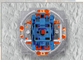
Schritt 2: Trennen Sie die Spannungszufuhr* des Schalters, an dem Sie arbeiten möchten. Entfernen Sie danach Abdeckung und Rahmen des Markenherstellers und legen Sie diese beiseite.
