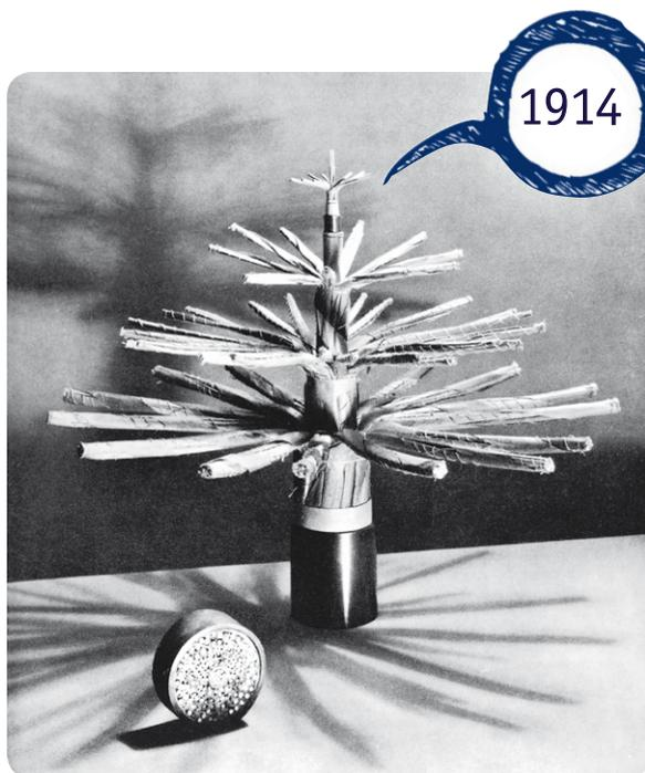
Bild 17: Hightech-Kabel von 1914 – pupinisiertes Fernmeldekabel
