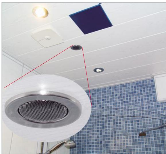
**Bild 11:** Deckenlautsprecher-Montage im Bad. Die Lautsprecherabdeckung hat das gleiche Design wie die Halogen- bzw. LED-Leuchten.
