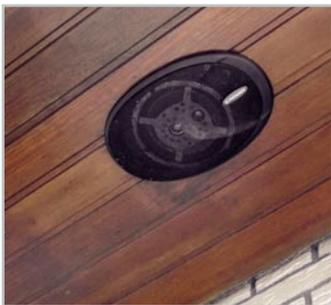
**Bild 14:** Geschützt untergebracht: Deckenlautsprecher in der Terrassenüberdachung
