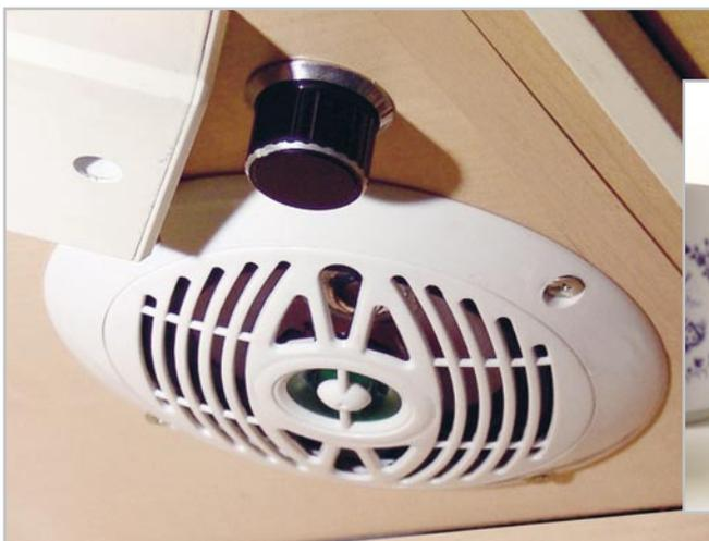
**Bild 4:** Der verdeckt eingebaute Marinelautsprecher im Eckschrank. Hier sieht man noch den bisher installierten Lautstärkeregler des Verstärkers. Innen schützt ein kleines Board den Lautsprecher vor dem „Nutzinhalt“ des Schrankes. Im Hintergrund ist die Hochton-Frequenzweiche zu sehen.
