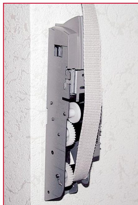
Bild 4: Nun einfach den EcoRoll auf die Schrauben des Gurtwicklers setzen ...
