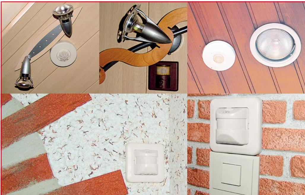
**Bild 3:** Herkömmliche Bewegungsmelder für das Schalten von Beleuchtungen fügen sich selten ins Ambiente ein.
