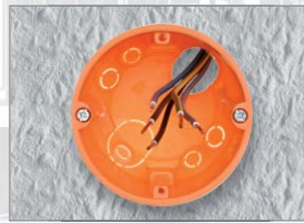
Schritt 3: Entfernen Sie den vorhandenen Unterputzeinsatz Ihres Markenhersteller-Schalters. Achten Sie hierbei auf die Spannungsfreiheit* am Schalter.
