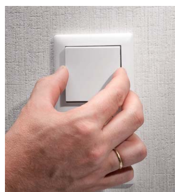
Bild 21: Abschluss der Installation: Einsetzen der Tasterwippe
