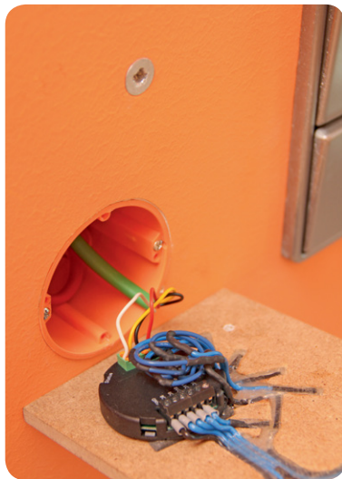
Bild 11: Nach der Verkabelung mit Bus und Stromversorgung ...
