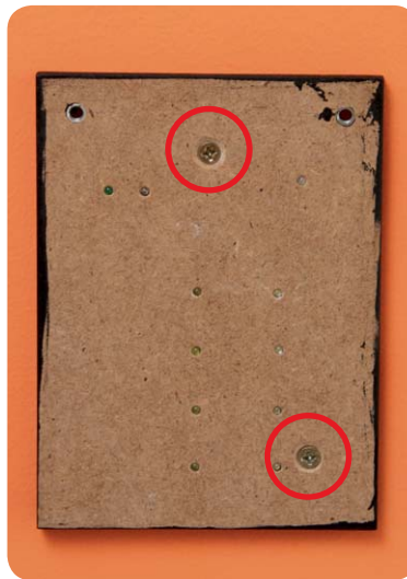
Bild 12: ... folgt das Anschrauben an der Wand.
