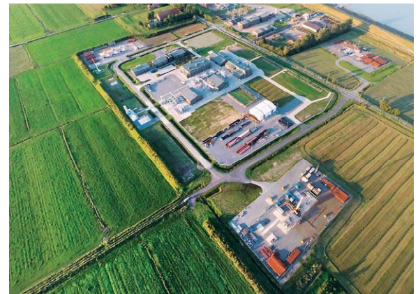
Bild 9: Im ostfriesischen Ort Jemgum soll bis 2023 die weltgrößte Redox-Flow-Anlage auf Polymerbasis entstehen. Bild: EWE
