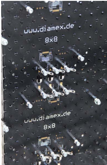
Bild 7: Bei der Montage der LED-Panels werden gleich noch die Lötösen für die Verdrahtung mit montiert.
