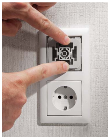
Bild 22: Der Abdeckrahmen des Installationssystems sowie der Wippenadapter werden aufgesetzt.
