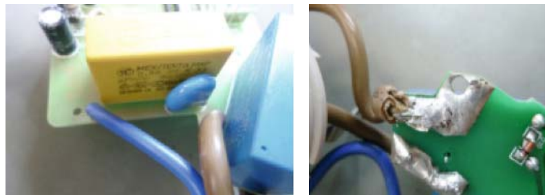
Bild 4: Nicht einmal einfach statt doppelt gesichert: falscher Anschluss von Netzleitungen
