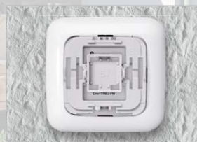
Schritt 5: Montieren Sie nun den zuvor entfernten Rahmen mithilfe des passenden Adapters zu Ihrem Schalterprogramm. Eine Übersicht finden Sie im Web-Shop.
