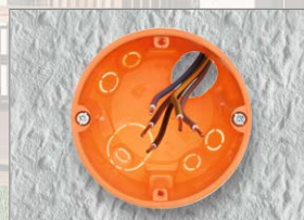
Schritt 3: Entfernen Sie den vorhandenen Unterputzeinsatz Ihres Markenherstellers. Achten Sie hierbei auf die Spannungsfreiheit* am Schalter.
