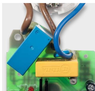
Bild 17: Nachgebessert: Netzleitungen sauber gesichert
