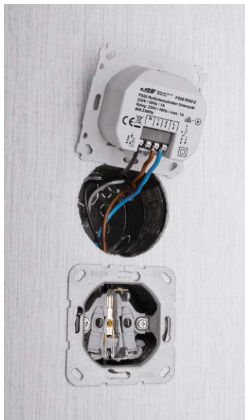
Bild 19: Verdrahtung des FS20 RSU-2
