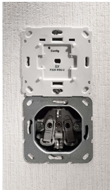
Bild 21: ... wird in die Installationsdose eingesetzt und verschraubt.
