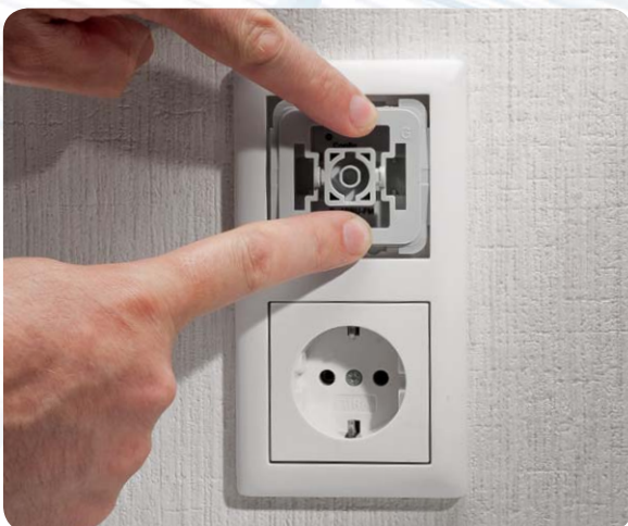
Bild 27: Der Abdeckrahmen des Installationssystems und der entsprechende Adapter werden aufgesetzt.
