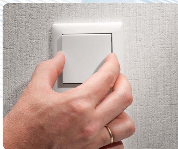
Bild 28: Abschluss der Installation: Einsetzen der Tasterwippe
