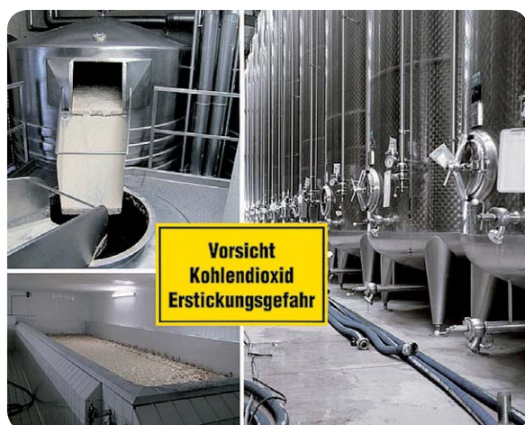
Bild 19: CO 2 in hohen Konzentrationen ist absolut tödlich! Kessel, in denen natürliche Gärprozesse stattfinden, dürfen daher nicht ohne vorherige CO 2 -Kontrolle betreten werden.
