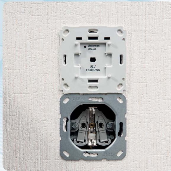
Bild 26: ... wird in die Installationsdose eingesetzt und verschraubt.
