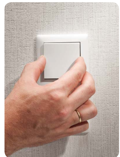
Bild 17: Abschluss der Installation: Einsetzen der Tasterwippe
