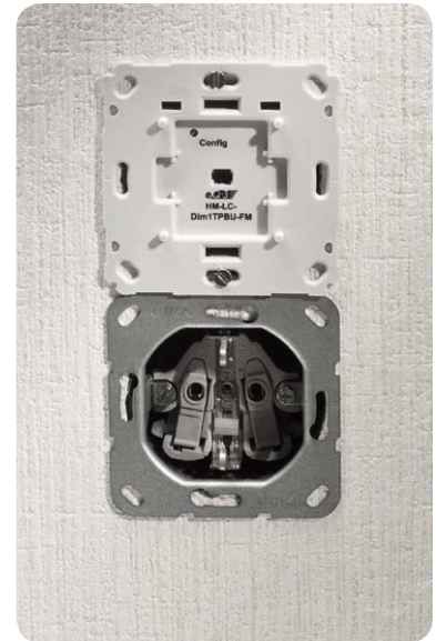
Bild 15: ... wird in die Installationsdose eingesetzt und verschraubt.
