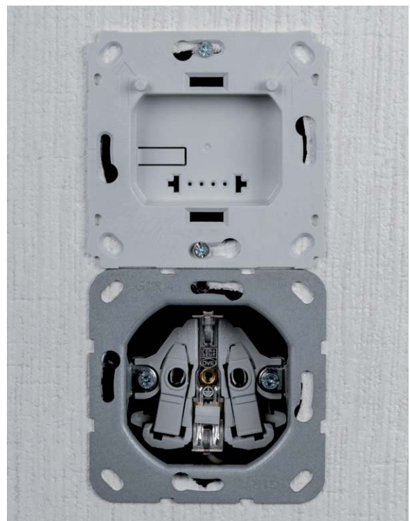
Bild 14: Die Montage ist auf einer Installations-/Schalterdose vorzunehmen, durch die der Systembus herangeführt wird.
