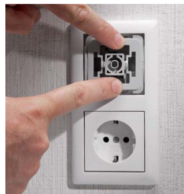
Bild 17: Der Abdeckrahmen des Installationssystems wird aufgesetzt.
