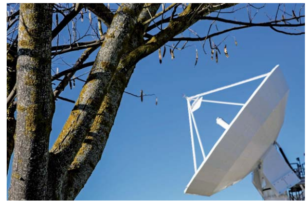
Bild 7: Über diese 13-m-Antenne in der EAN-Satelliten-Bodenstation in Nemea, Griechenland, wird der satellitenbasierte Datenverkehr zwischen S-Band EAN/Hellas Sat 3 und Flugzeug abgewickelt.
