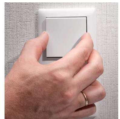
Bild 18: Abschluss der Installation: Einsetzen der Tasterwippe
