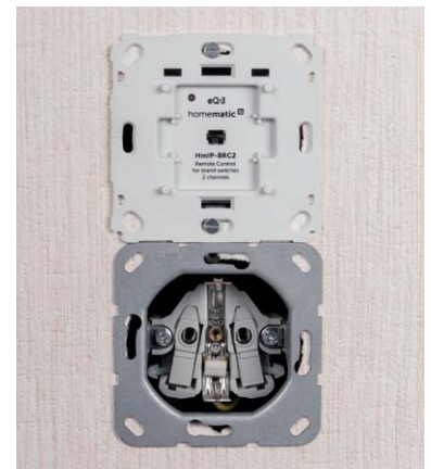
Bild 16: ... wird in die Installationsdose eingesetzt und verschraubt.
