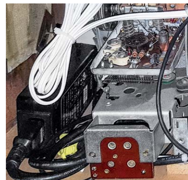
Bild 10: Das Notebook-Netzteil wurde mit im Gehäuse untergebracht.
