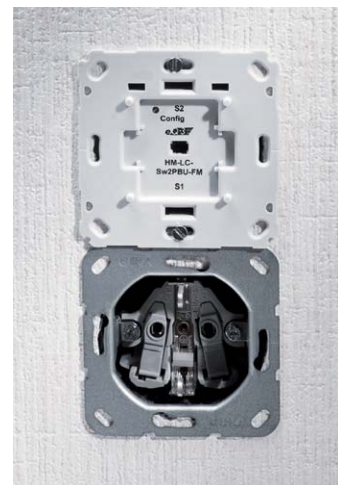
Bild 23: ... wird in die Installationsdose eingesetzt und verschraubt.
