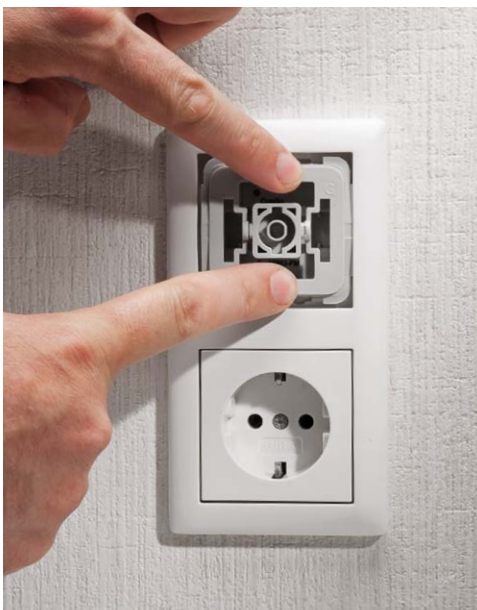
Bild 18: Der Wippenadapter des Installationssystems wird aufgesetzt.
