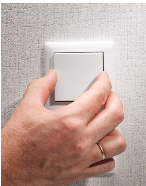
Bild 19: Abschluss der Installation: Einsetzen der Tasterwippe
