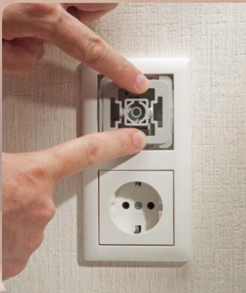
Bild 22: Der Abdeckrahmen des Installationssystems wird aufgesetzt.
