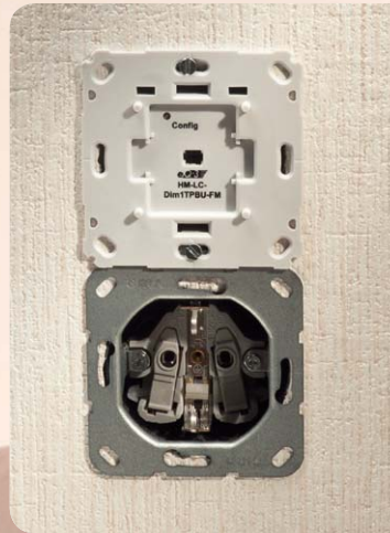
Bild 21: ...wird in die Installationsdose eingesetzt und verschraubt.
