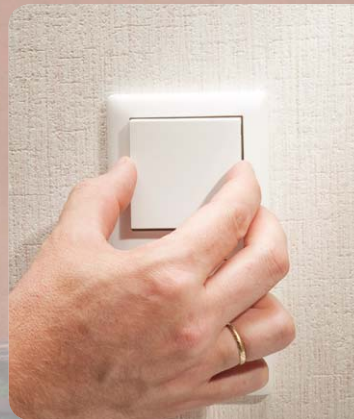
Bild 23: Abschluss der Installation: Einsetzen der Tasterwippe
