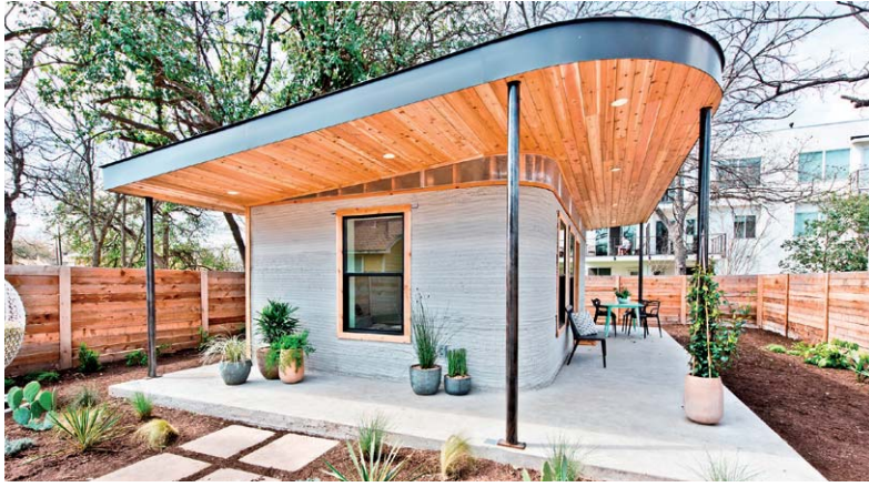
Bild 8: In 24 Stunden erbaut, Rohbaukosten gerade 4000 Dollar – das von Icon entwickelte Kleinhaus wird mit einer speziellen Lavastein-Zementmischung von einem 3D-Drucker errichtet. Foto: Icon
