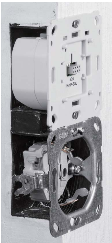
Bild 25: So erfolgt die Montage in eine Unterputzdose.
