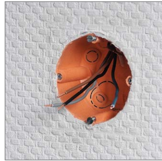
Bild 3: Bevor der Schalter ganz entfernt wird, sollte man sich die Anschlussbelegung notieren.
