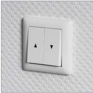
Bild 1: Bevor der bestehende Rollladenschalter umgerüstet wird, ist der zugehörige Stromkreis auszuschalten.
