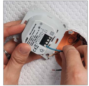
Bild 4: Vor dem Anschluss des HomeMatic Funk-Rollladenaktors sollte die Seriennummer notiert werden, da diese für den Anlernvorgang erforderlich ist. Danach kann der Aktor verdrahtet werden.
