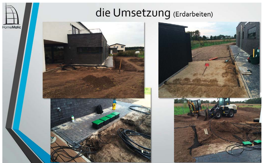
Bild 2: Vorbereitende Maßnahmen, Wasser- und Elektroleitungen nach Plan verlegen
