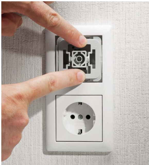
Bild 17: Der Abdeckrahmen des Installationssystems wird aufgesetzt.
