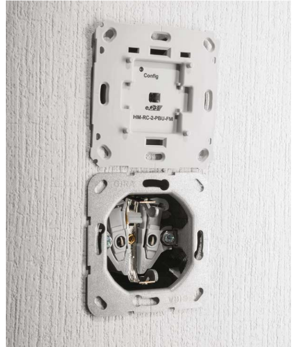
Bild 16: ... wird in die Installationsdose eingesetzt und später verschraubt.
