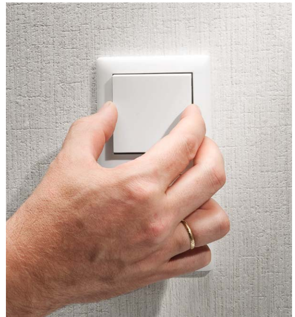
Bild 18: Abschluss der Installation: Einsetzen der Tasterwippe
