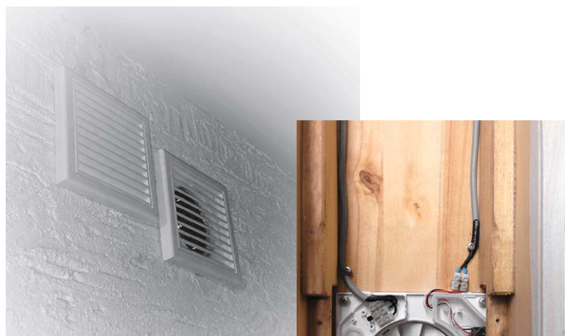
Bild 5: Ab- und Zuluftöffnung liegen dicht nebeneinander in der Außenwand und sind deshalb versetzt montiert. Zusätzlich sind die Zu- und Abluftrohre in der Wand mit leichtem Gefälle eingebaut, um entstehendes Kondensat nach außen abzuleiten. Außerdem wurden in den Luftkanälen Edelstahlrückschlagklappen installiert, um die Wärmedämmung zu verbessern.
