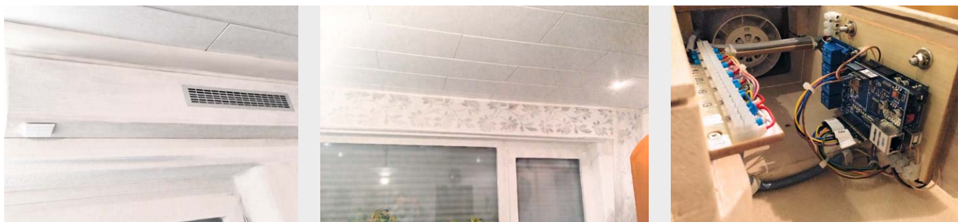
Bild 10: Die Montage des Wärmetauschers und der Steuerungskomponenten
