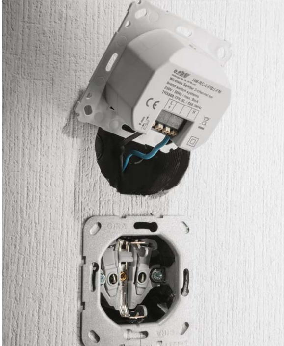
Bild 15: Der fertig verkabelte Aktor ...
