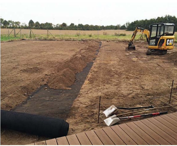
Bild 3: Wasserleitungen, Erdschicht, Maulwurfsperrung und anschließend Wasserturbinen bodeneben einbauen. Der Minibagger sparte bei den vielen zu verschiebenden Kubikmetern Erde viel Zeit.
