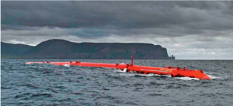
Bild 11: Mit dem Projekt Pelamis soll im großen Maßstab Energie aus den Wellenbewegungen an der Oberfläche der See geerntet werden.
