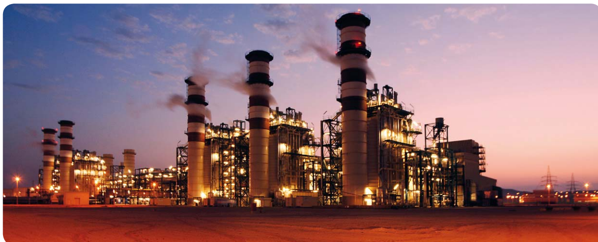
Bild 37: Technologieführer im Kraftwerksbau – das GuD-Kraftwerk mit Meerwasserentsalzungsanlage ist absolute Hightech in der arabischen Wüste.
