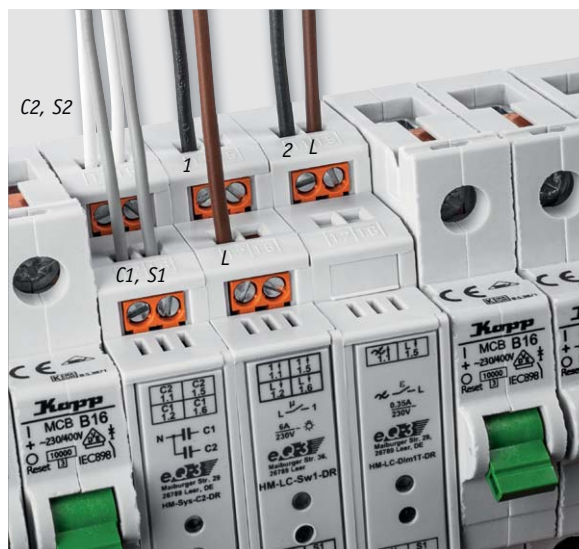
Bild 12: Anschlussbeispiel für die Kombination des Kompensators mit zwei Schaltaktoren
