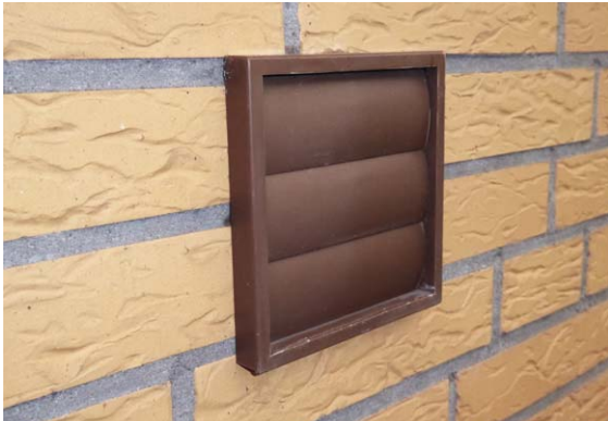
Bild 6: Günstige Entlüftungslösung – ein Abluftventilator in der Außenmauer
