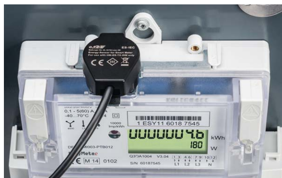
Bild 14: Montage des Sensors über das Original-Tastkopfblech am EasyMeter-Drehstromzähler Q3D
