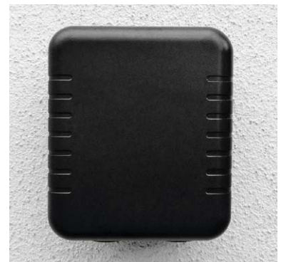
Bild 3: ... der zweite in einem Wetterschutzgehäuse mit Klappdeckel an der Garagenaußenwand.
