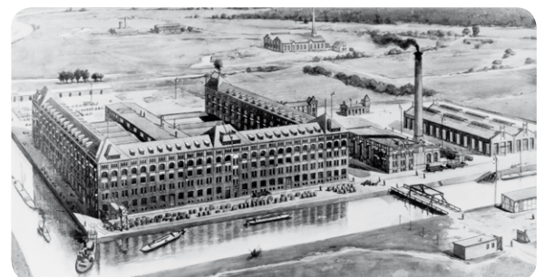
Bild 14: Rings um das Kabelwerk Westend am Nonnendamm entstand Siemensstadt.
