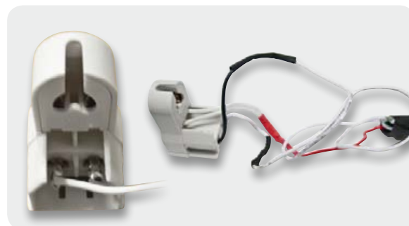
Bild 8: Mangelhafte Isolierungen der Netzspannung führenden Leitungen
