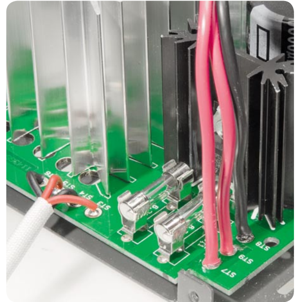
Bild 22: Anschluss der sekundärseitigen Trafoleitungen
