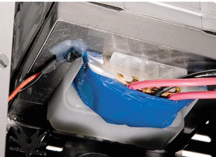
Bild 20: Montage des Temperatursensors am Netztrafo
