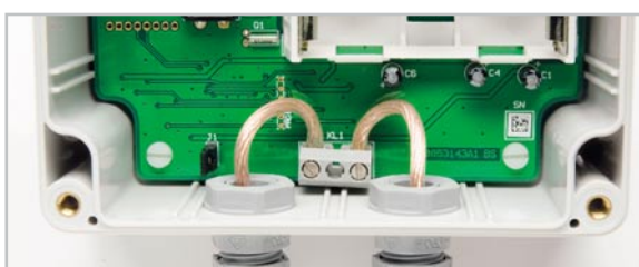
Bild 7: Die Montage und der Anschluss der Messleitung im Gehäuse der Mess-Station
