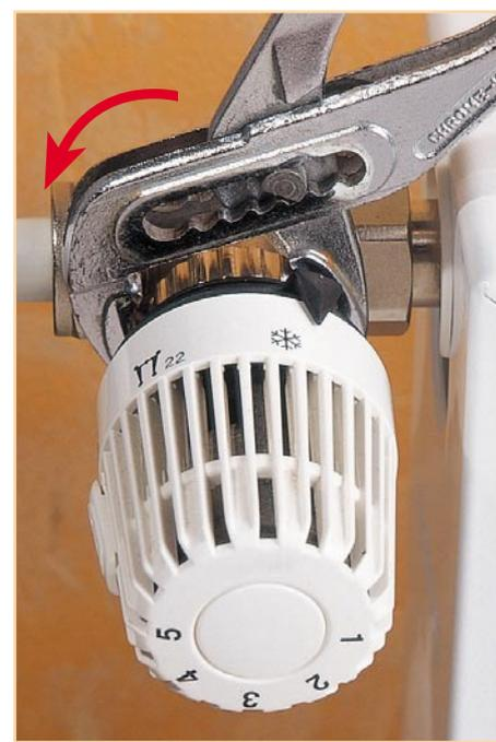
**Bild 2: Demontage des mechanischen Heizkörperthermostaten**
