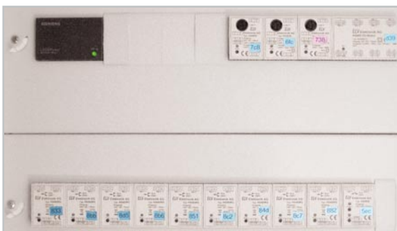
Bild 2: Die HS485-Komponenten sind im Sicherungskasten und den Etagenverteilern eingebaut, hier ist u. a. oben rechts das Universal-I/O-Modul HS485 IO127 zu sehen.
