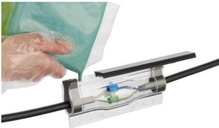
9. Den Schiebedeckel der Muffe so zurückschieben, dass eine kleine Öffnung vorhanden ist. Durch diese Öffnung das Gießharz in die Muffe gießen.
