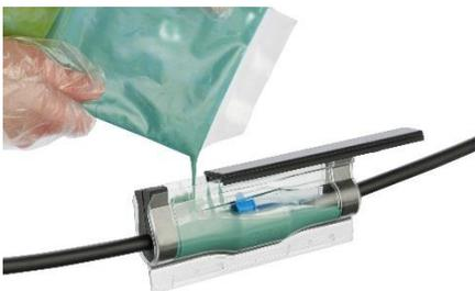
12. Muffe komplett mit Gießharz ausfüllen, da sonst keine Wasserdichte garantiert werden kann.
