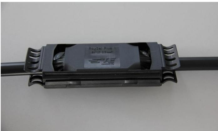
**7.** Beim schließen darauf achten, dass die ISO FLEX Gelmuffe Größe M korrekt schließt und einrastet. An den Enden austretendes Gel kommt durchaus vor und ist durch die Verdrängung durch das Kabel zu erklären.
