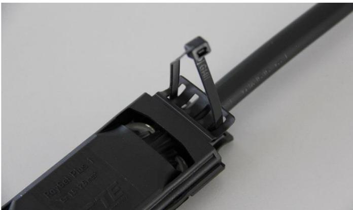
**8.** Zur Zugentlastung die beiden mitgelieferten Kabelbinder verwenden und durch die dafür vorgesehenen Ösen an den beiden Enden der ISO FLEX Gelmuffe Größe M ziehen. Nun ist die Kabelverbindung fertig und bei richtiger Anwendung wasserdicht und trittfest.
