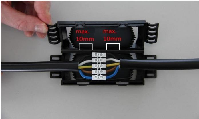
**5.** Die Kabelverbindung mittig in die offene ISO FLEX Gelmuffe Größe M legen. Auf beiden Seiten der Kabelverbindung muss ein Stück des Kabels mit Außenummantelung (ca. 10mm) bis in die Gelmuffe ragen, um eine sichere wasserdichte Kabelverbindung herzustellen.
