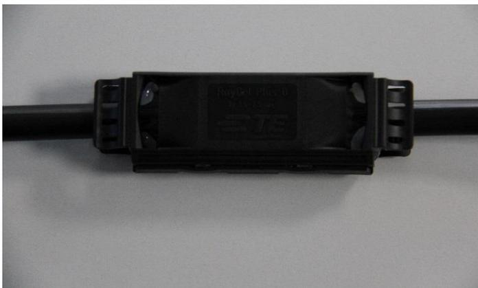
**7.** Beim schließen darauf achten, dass die ISO FLEX Gelmuffe Größe S korrekt schließt und einrastet. An den Enden austretendes Gel kommt durchaus vor und ist durch die Verdrängung durch das Kabel zu erklären.
