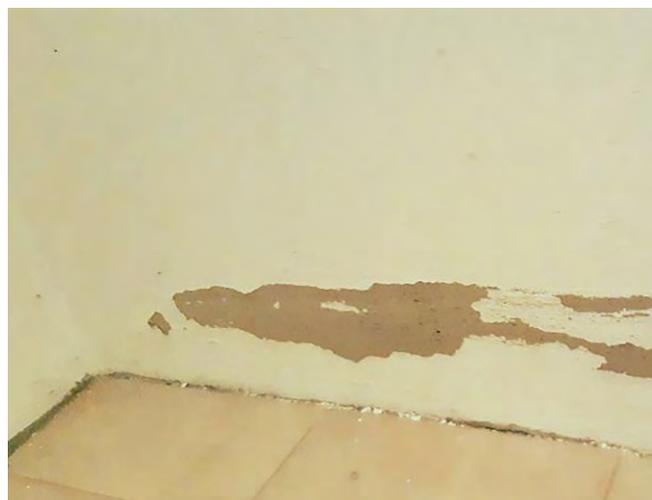
Bild 6: Feuchteschäden in einem Kellerraum - früh erkannt mit DHT11 und Python
