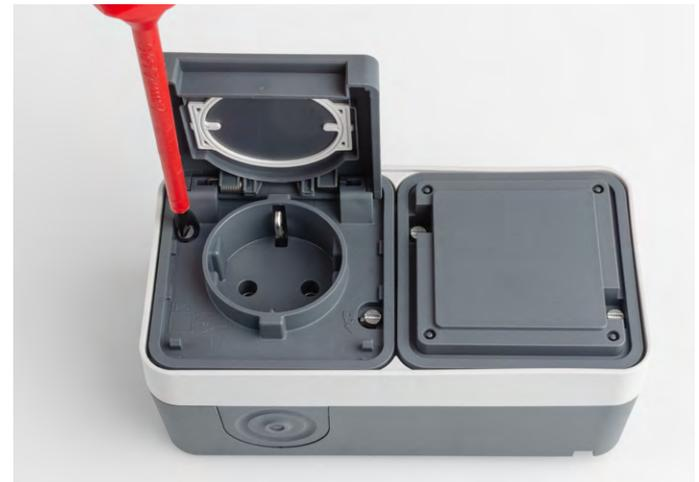
Bild 13: Dose mit den vier Spezialschrauben verschließen
