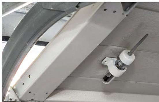
Bild 3: Torerkennung durch Lageänderung, Tür-/Fensterbewegung durch Erschütterung
