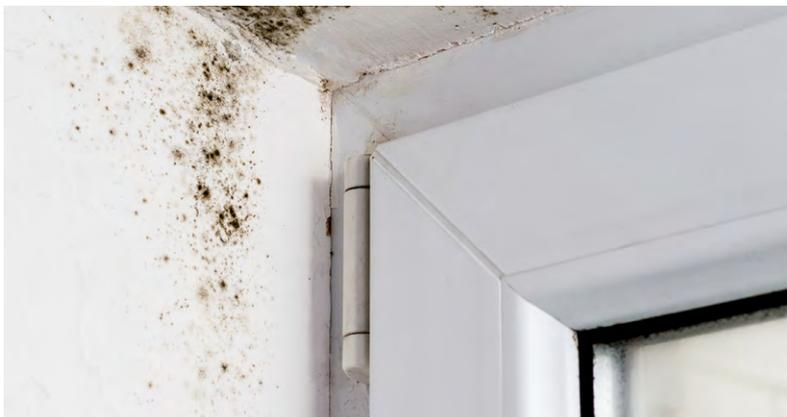
Bild 1: Schimmelausbreitung wird insbesondere durch Feuchtigkeit begünstigt.
