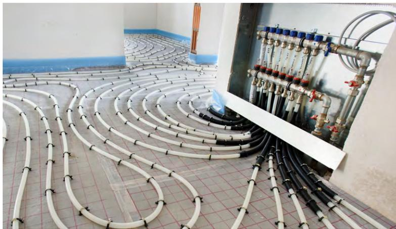
Bild 8: Fußbodenheizung mit Heizkreisverteiler
