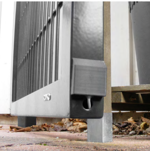
Bild 6: Alarmkontakt fertig montiert
