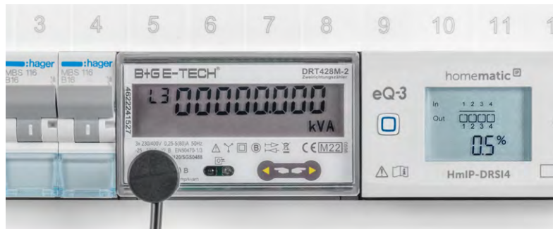
Bild 2: Montierter ES-LED-Sensor
