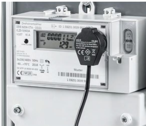
Bild 3: Montierter ES-IEC-Sensor
