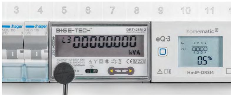
Bild 2: Montierter ES-LED-Sensor
