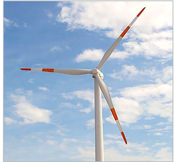
Bild 1: Beispiel für eine Windkraftanlage. Solche Anlagen bestehen im Prinzip aus vier Bauelementen, von unten nach oben: dem Fundament, dem Turm, der Maschinengondel und dem meist dreiflügeligen Rotor (auch: Windrad). Bei jeder Umdrehung passieren die meist drehbaren Rotorblätter nacheinander den Turm und erzeugen dabei jeweils einen impulsartigen Schall. Bei drei Rotorblättern und den üblichen Drehzahlen ergibt das eine ausgeprägte Impulsspitze bei ungefähr 1,5 Hz, und somit ist das Infraschall.
