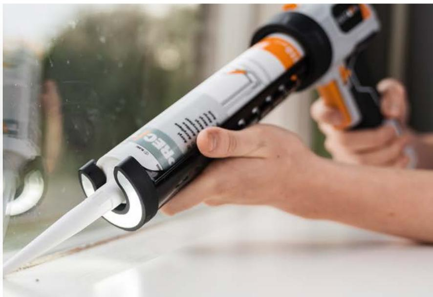
Jeder, der schon einmal eine Silikon- oder Acrylfuge mit einer Kartuschenpresse gezogen hat, kennt die Probleme, die dabei auftreten können – täglich damit umgehende Handwerker ausgenommen: Man muss ständig per Hand nachdrücken, für gleichmäßigen Materialaustritt muss man geübt sein, und besonders lästig ist der Materialaustritt nach dem Absetzen.
